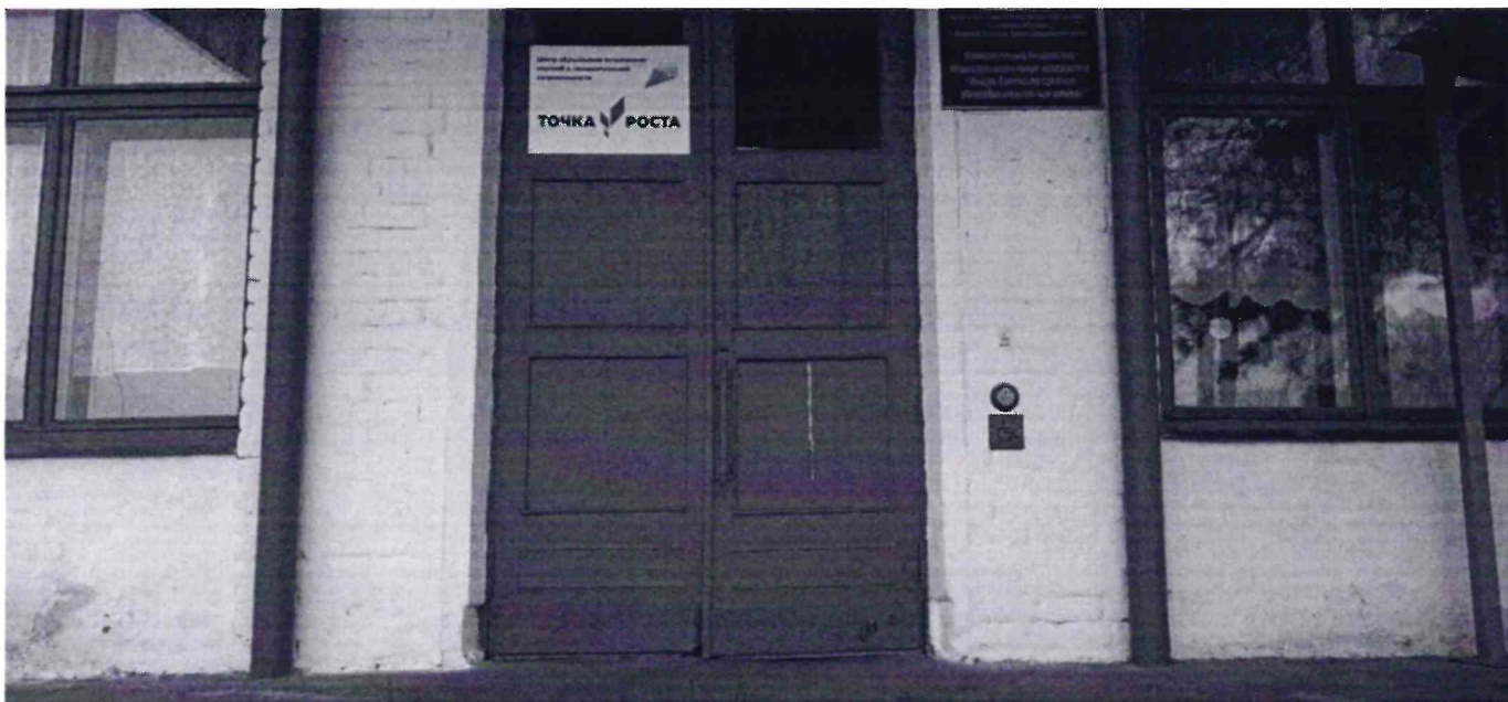
Фото входа (входов) в здание
